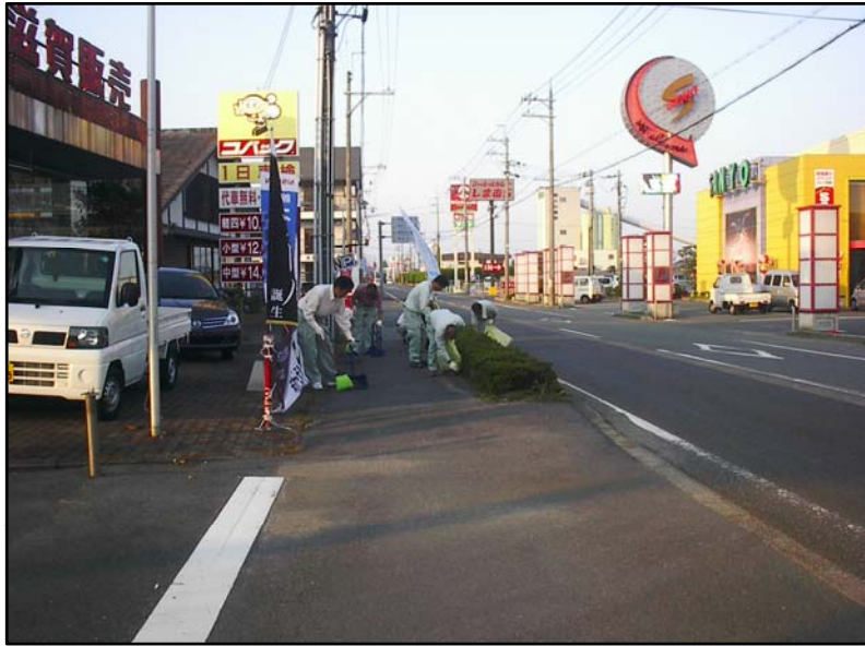
位置： 県道新旭高島線 撮影日： 平成22年10月度
